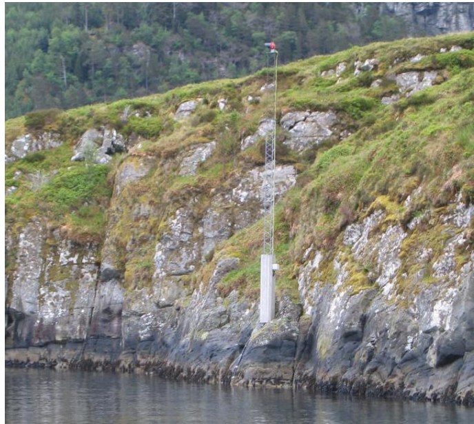
Det står to gittermaster på nordvestre del av Tennøyane. Foto: Heidi Sandvik
