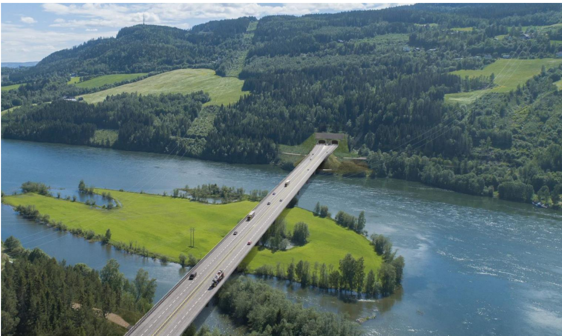
Figur 2-5. Lågen bru, mot Trosset
