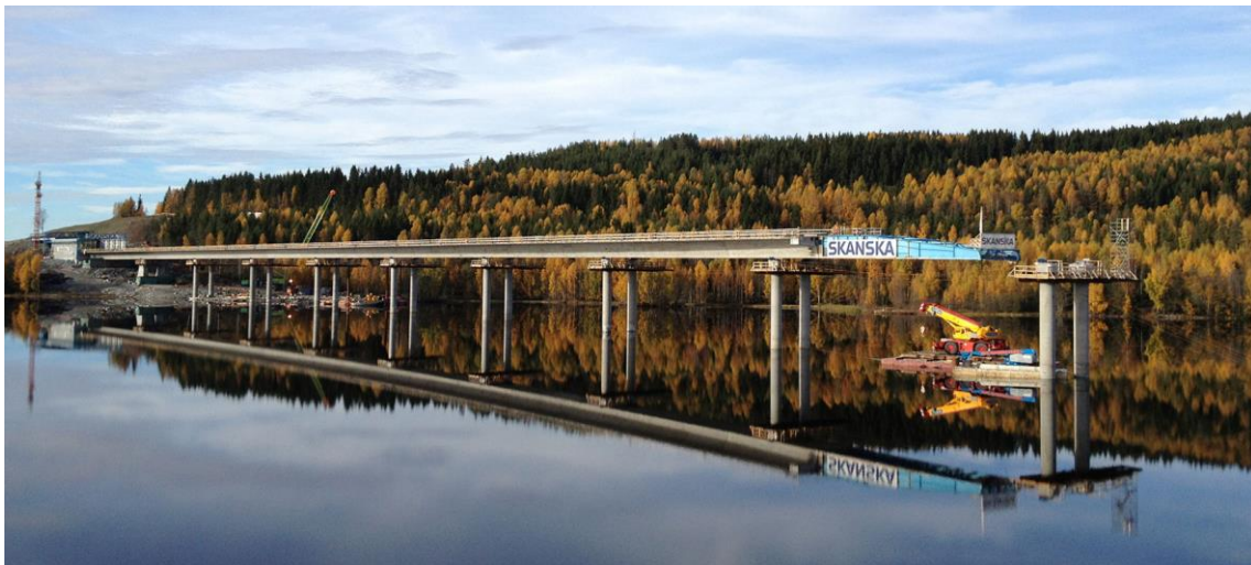
Figur 2-7. Eksempel på lanseringsmetoden, Gulli bru over Glomma ved Kongsvinger.
