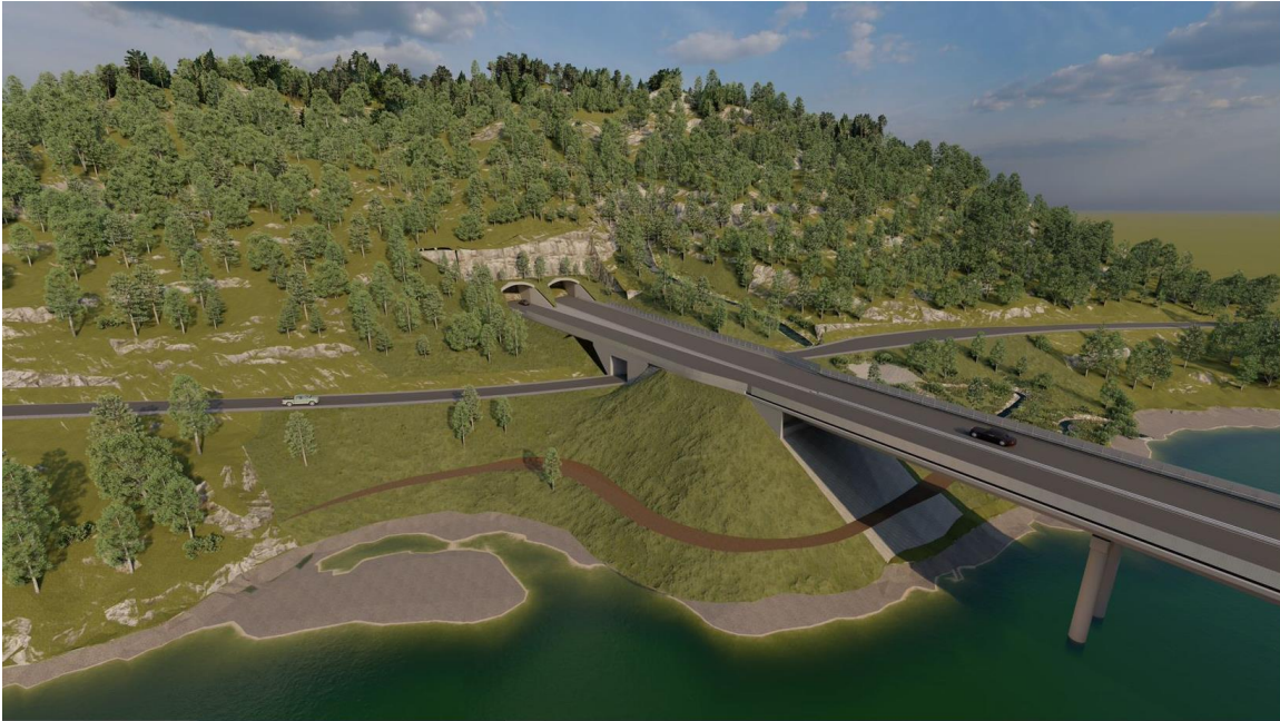
Figur 2-4. Illustrasjon av fylling under søndre landkar Lågen bru.
