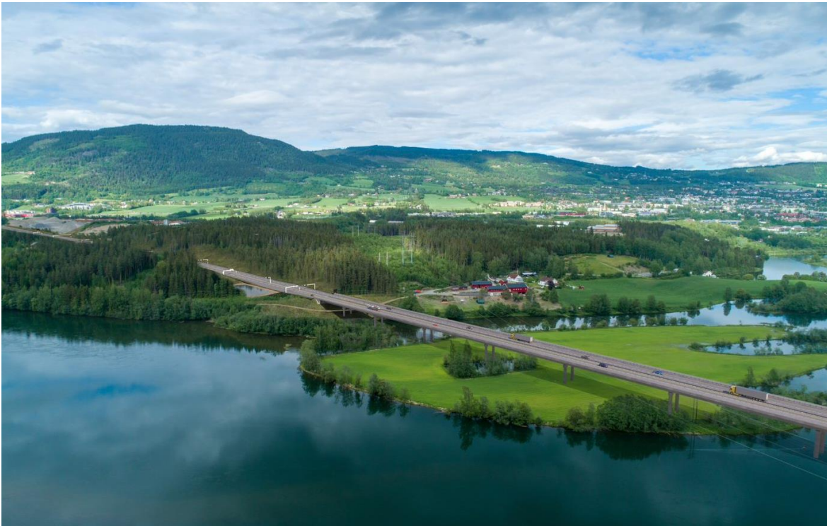
Figur 2-6. Lågen bru, mot Hovemoen. Dagens landbruksvei/turvei føres under brua.
