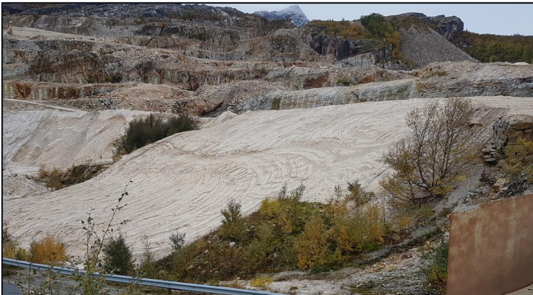
Fig. 4.6 Nyere deponi fra 2020, arrondert før planlagt tildekking med stedlige masser våren 2021
