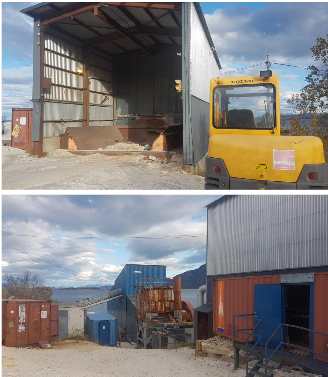
Figur 4: Knuse- og siktverk.
