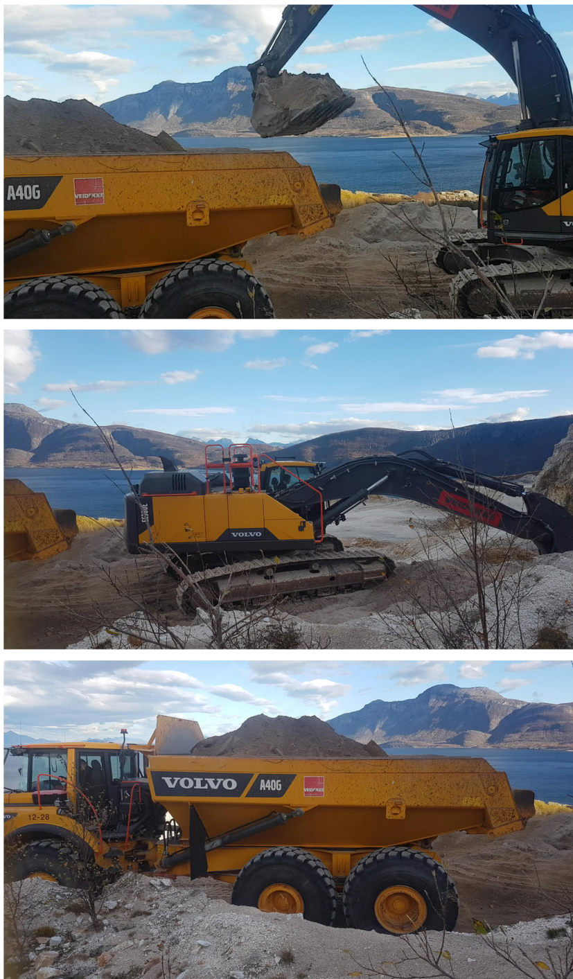
Figur 7: Lasting med gravemaskin til dumper og transport ned til knuseverk.
