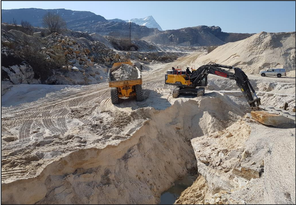
Fig. 4.3: Tømming av slambasseng med beltegraver og dumper
