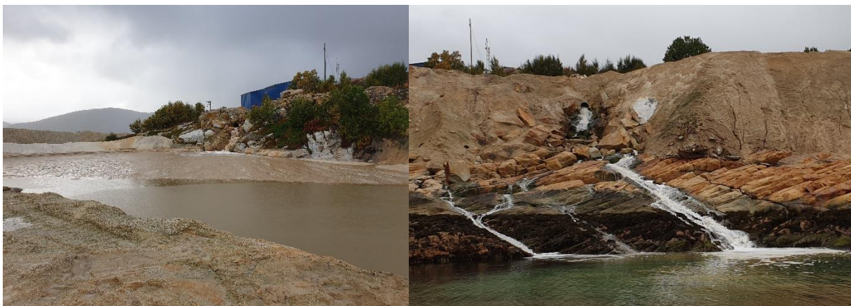
Figur 2: Sedimentasjonsbasseng på land (venstre) og utslipp av prosessvann (høyre). Bildet av bassenget er tatt 16.09.2020, 2 uker før tømning.
