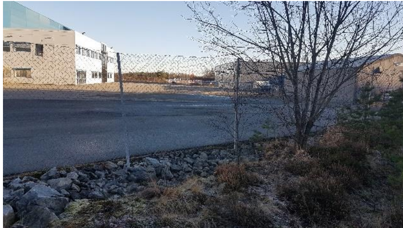
Figur 2 Bygg med omkringliggende arealer. Bildet tatt sørvest for bygget.
