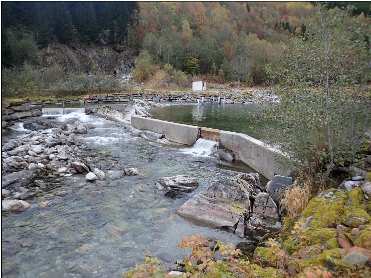
Figur 5. Dam ved inntaket til Hoelsfossen kraftverk.
