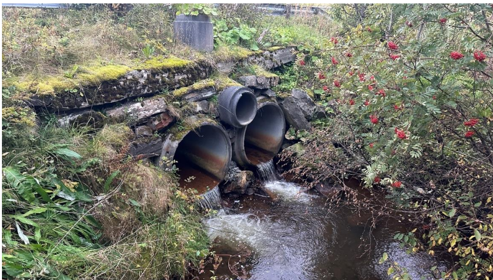
Figur 3-43. Kulvert der Sandblåstvegen krysser Røstløken.
