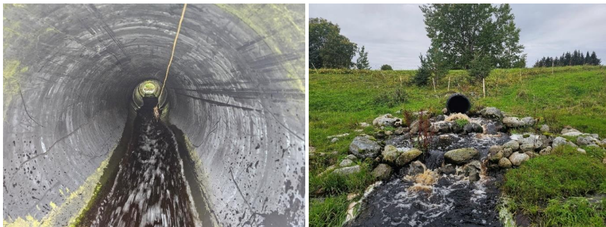
Figur 3-23. Vandringshinder i Rokstadelva.
