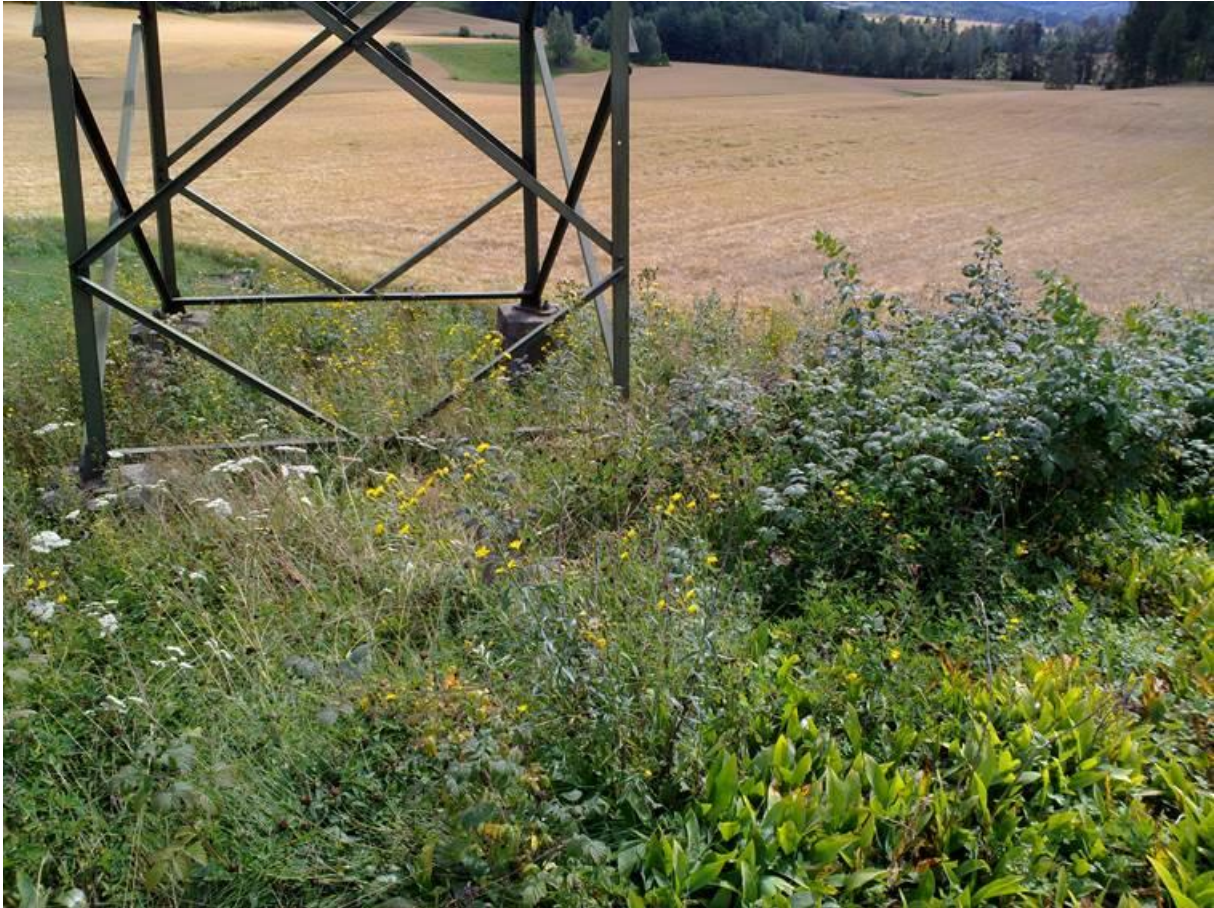
Foto 30 Kantsone 3, Skarraenga i Vestfossen i Øvre Eiker kommune 12. august 2019, nedover. Foto: Roald Bengtson.
