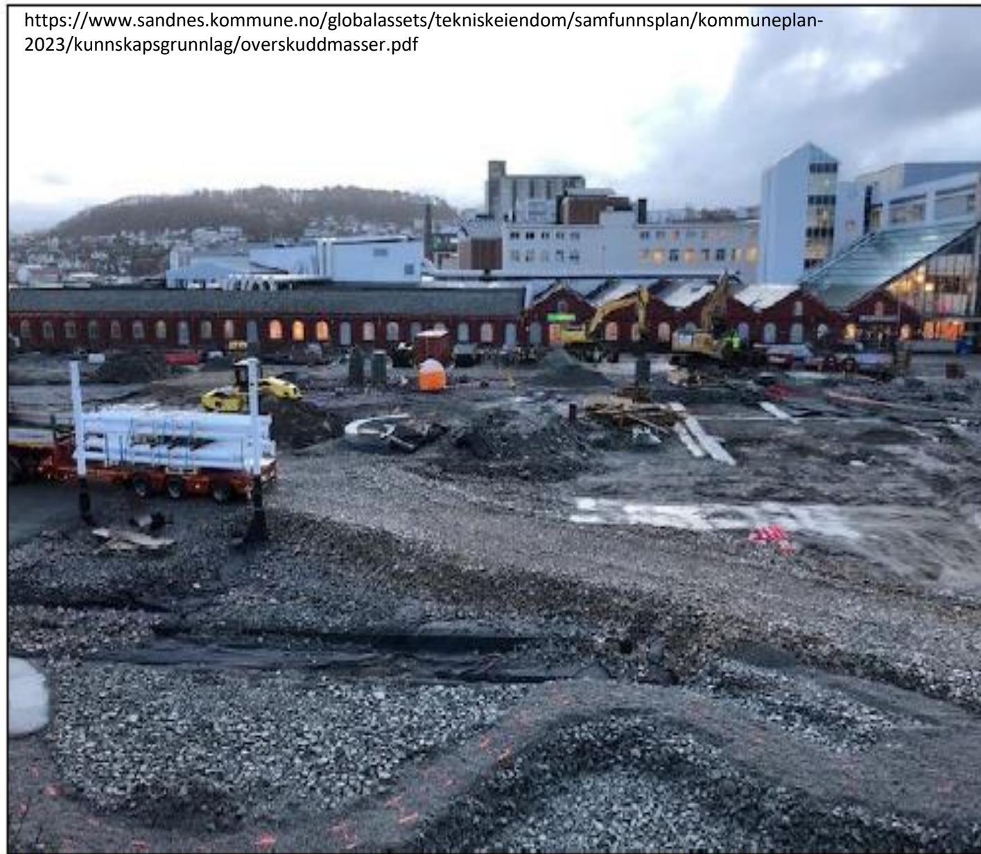
Nye Ruten i Sandnes sentrum under oppfylling med vaskede og sorterte gjenbruksmasser
