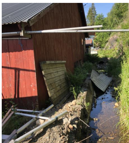
Hellefjorden bekkefelt, sjøørretførende bekk ved Helle småbåthavn, foto før tiltak i 2020
