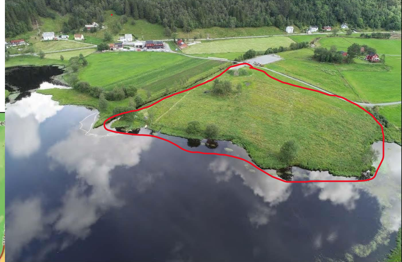
Fig. 5. Deponiområdet på Unneland før oppstart av anleggsarbeidet. 9. august 2019. Foto: Veidekke AS.
