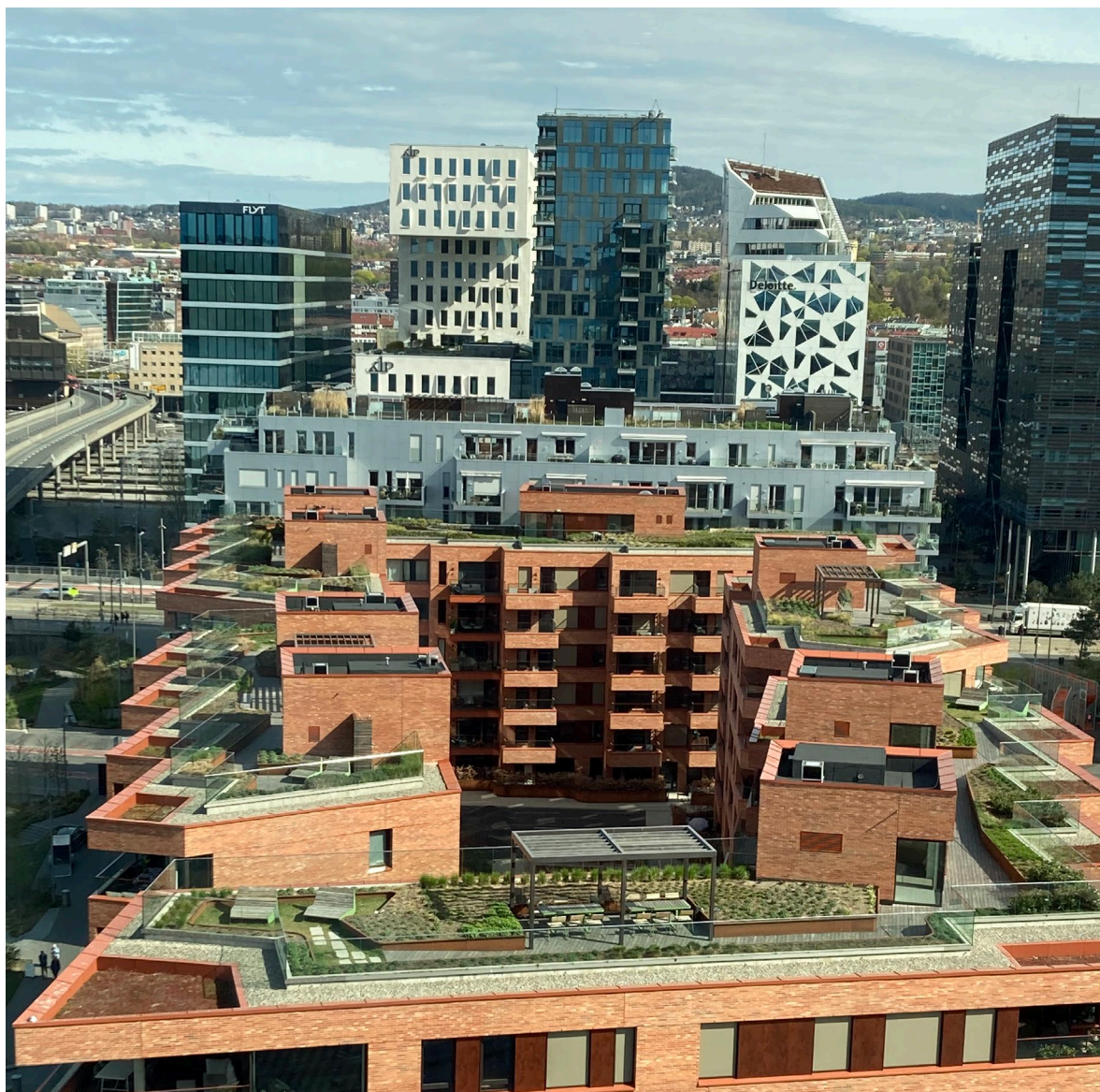
Bilde fra Oslo, bak Munchmuseet. I sentrumsarealer finnes det lite ledige areal på bakkenivå. Men takflater og terrasser kan benyttes, så sant takkonstruksjonen er planlagt til å tåle belastningen jord og planter gir. Foto: Arne Sæbø, NIBIO.
