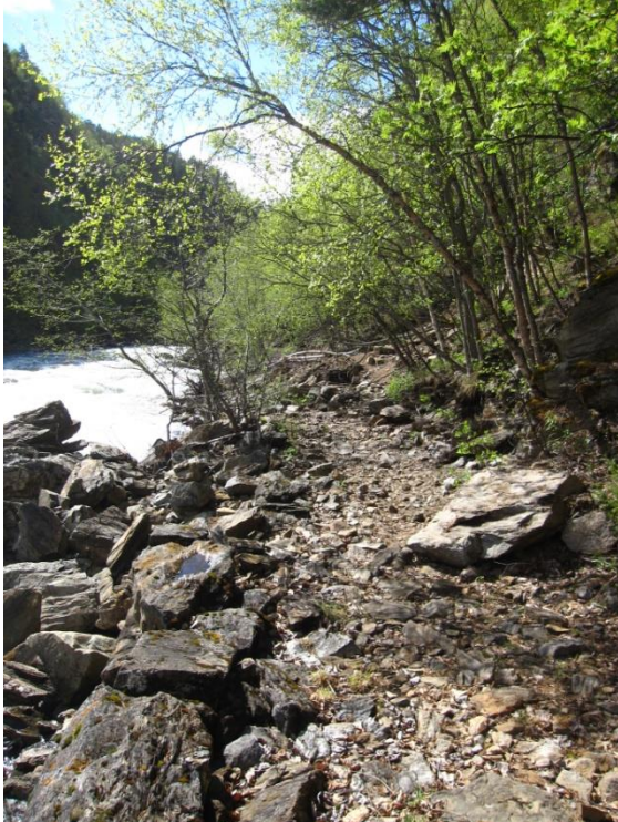
Bilde 6: Strekning av gamleveien som ble ødelagt av ras og flom i 2010. Foto: Christian Brun-Jenssen/Fylkesmannen i Nordland.
