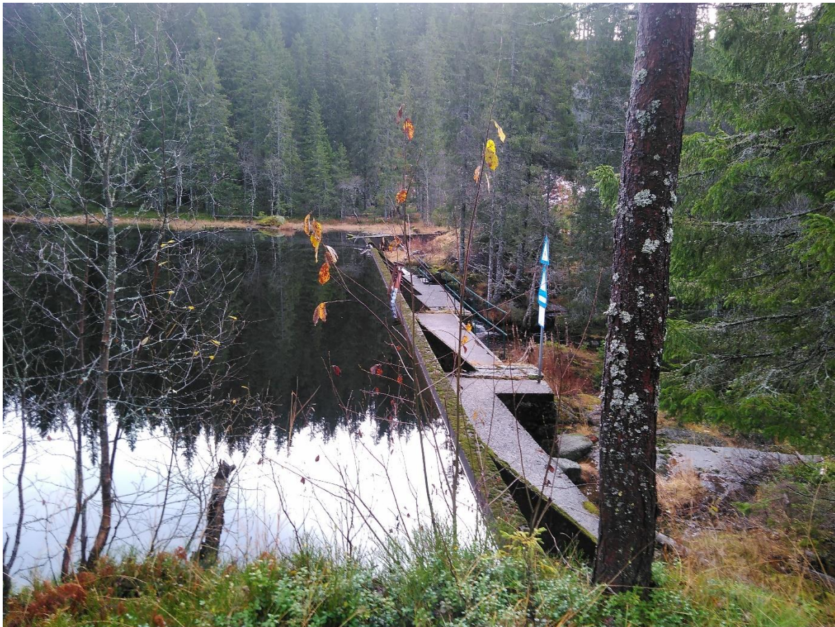
Bilde 4: Dammen i Åslivatn
