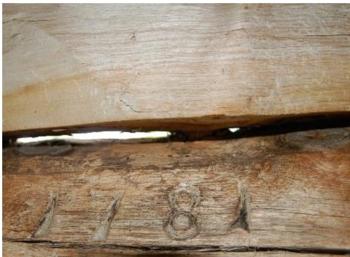
Figur 19. Årstallet 1781 er skåret inn i tømmerveggen i Krokøløa. Foto: B. Bele/NIBIO.
