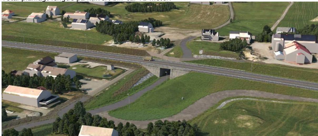
Figur 7-8-12: Kulvert Nordre Ådlandsveg – sett fra øst. Illustrasjon COWI
