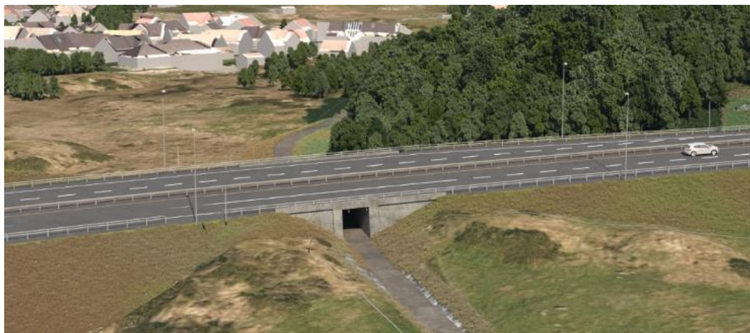
Figur 7-8-3: Kulvert for turveg sør for Mariaskogen – sett fra øst. Illustrasjon COWI
