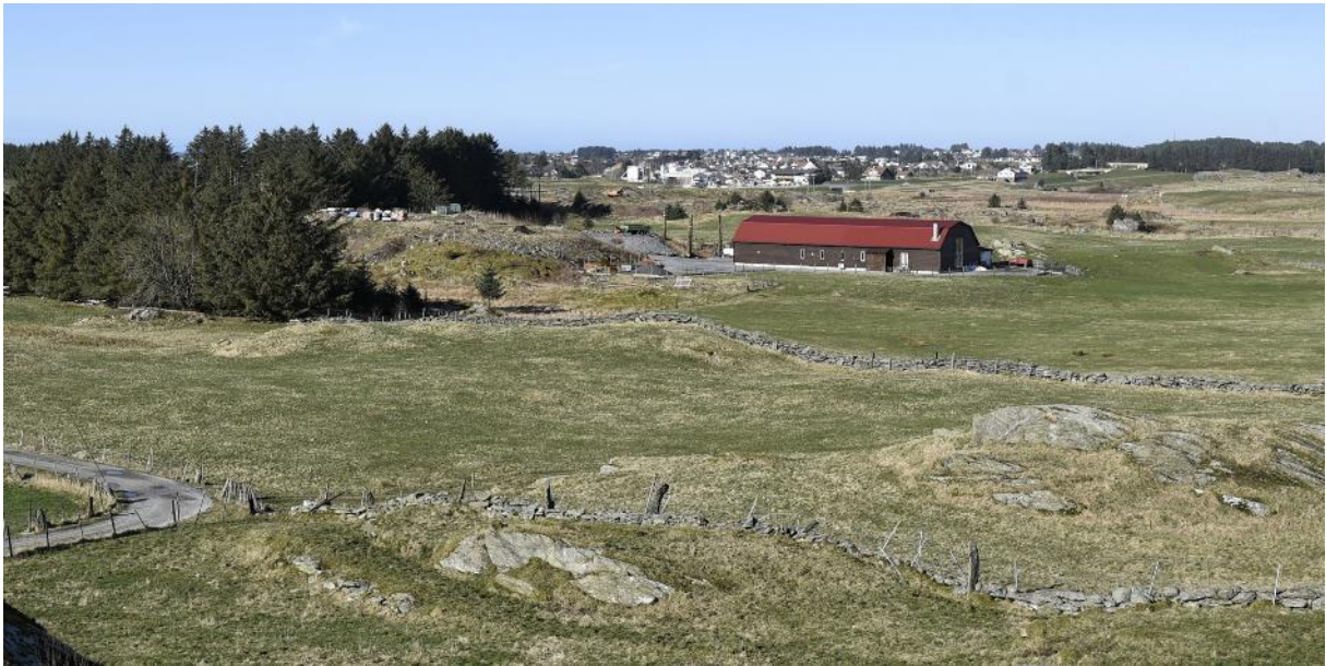
Figur 8-6-11: Veganlegget sett fra Netta mot nord. Kulvert for Årvollåna ved Myrdalskrysset kan ses over bygning med rødt tak. Åkravegen bru ses i øvre høyre billedkant.
