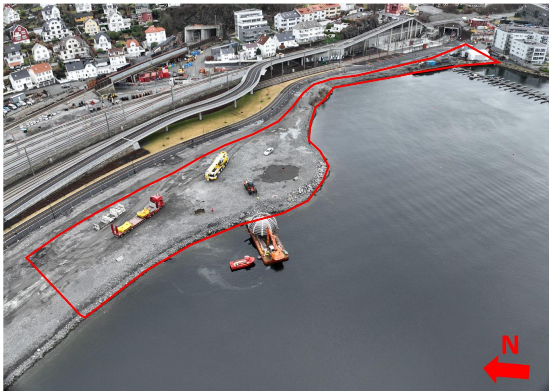
Figur 10 Rødt polygon markerer området ved Fløen/Bybaneutfyllingsområdet (Figur 1) i den øst-nordøstlige delen av Store Lungegårdsvann som kan benyttes som riggområde. Den østlige enden av området benyttes i dag som riggområde for skrottryddingen som pågår i Store Lungegårdsvann.
