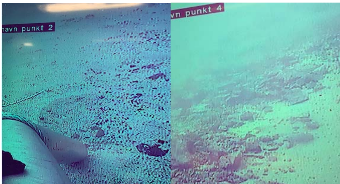
Figur 6: Til venstre: Fjerning av toppmasser med sandsug ved stasjon 2. Høyre: Typisk grovfraksjonert masse ved kaifronten som hindrer større skip å legge til kai.
