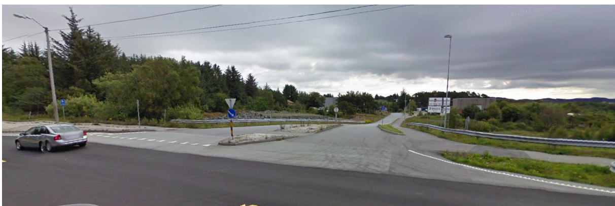
Figur 7: Plassering av gangfelt over vikepliktig sideveg (Figur 8.3 i håndbok N302 s. 67).
