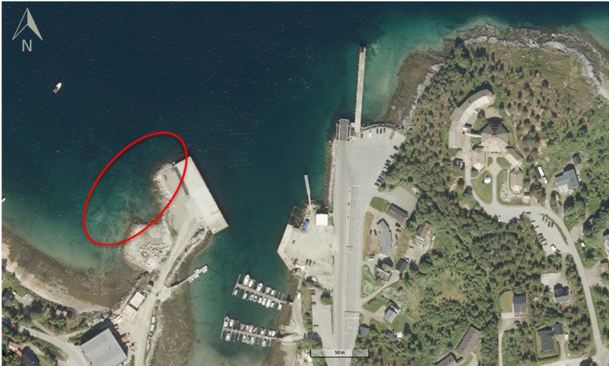
Figur 2: Ortofoto over havneområdet på Drag. Fergekaien ligger i nordøst og industrikaien i vest. Området hvor det planlegges utfylling ved industrikaien er markert med rød sirkel (kilde: norgeskart.no).
