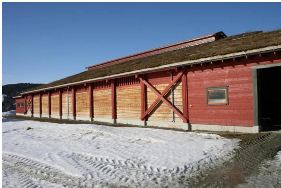
Pilot i det nasjonale prosjektet «Landbruksbygg i tre». Bygd i 2013. Bygningsmål ca 22x47 m medrekna forsentral og mjølkerom/birom. Prefabrikkerte søylefeste i betong og heiltresøyler. Taktolar (Kvatro AS) i buntar på søylene og spikra/skrudd massivt tretak i stående 50 x 150 mm plank. Torvtak.
