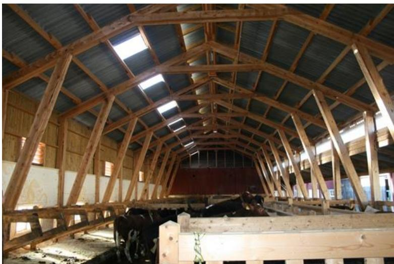
Til konstruksjon er 12 meter treleddsramme frå Landbygg AS brukt. Konstruksjonen er utan innvendige stolpar. Byggherren skaffar tømmer som er kappa og kanta etter mål frå Landbygg. Tømmeret blir kappa og montert saman på bakkeplan før tømmerramma blir heist opp. Hos Liabø vart tømmeret kjøpt frå Tømmervåg Tre AS på Tustna som hadde fresa dei ulike spora i stokkane på førehand før dei ble transportert til Liabø. Veggane er plassbygde i tre.
