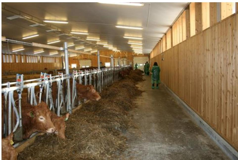
Isolert himling (35 cm) med luftekanalar og naturleg ventilasjon. Mauset har valt å isolere himlinga for å unngå risiko for rust på spikerplatene i takstolane. I dei langsgåande luftopningane er det brukt perforerte aluminiumsplater med 46% luftgjennomgang. Brukar meiner desse har lengre levetid enn duk. Ved kalde periodar blir deler av luftekanalane stengde slik at temperaturen blir > 0 grader.
