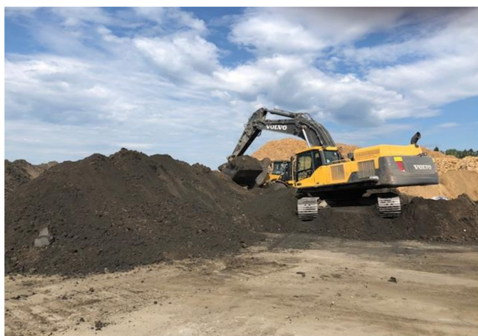
Figur 1. Utlegging og miksing av massene med gravemaskin
