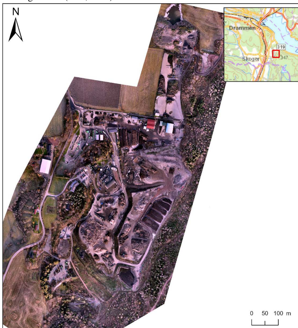
Figur 1 Oversiktsbilde over Lindum Drammen (dronefoto, november 2019).
