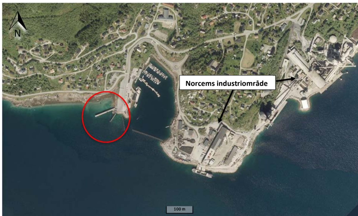
Figur 2: Ortofoto over havneområdet i Kjøpsvik. Området hvor det planlegges tiltak ved fergeleiet er markert med rød sirkel. Norcems industriområder med tilhørende kaier ligger øst for fergeleiet (kilde: norgeskart.no).
