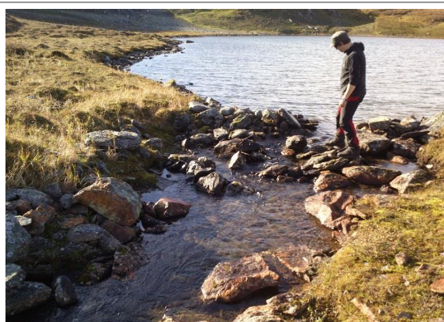
Vandringshinder, trolig anlagt for å hindre utsatt fisk å vandre ut av tjønna. Fri vandringsvei for fisk er gjenopprettet ved å fjerne stein og åpne opp elveløpet.
