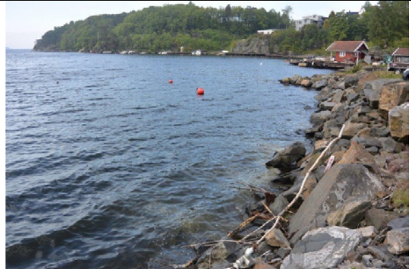
Bilde 2. Fylling mot sjø i vestre bukt.
