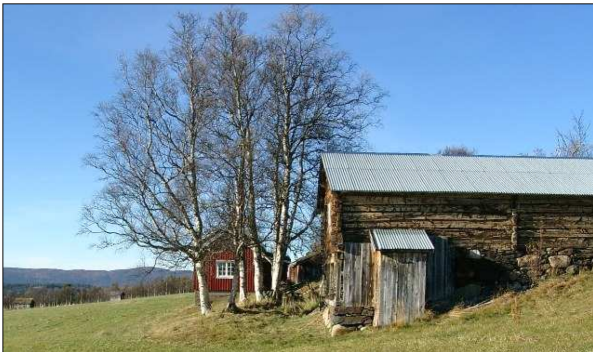
Figur 6. Bygningsmassen på heimesetra til bnr. 173/3 i Storbudalen er godt bevart. Her står fire bygninger; fjøs (fremst), seterbu, kokhus og saufjøs. Setervollene her er oppdyrket og høstet maskinelt.
