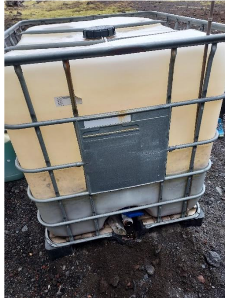
Lekkasje fra kontainer ved tank 1
