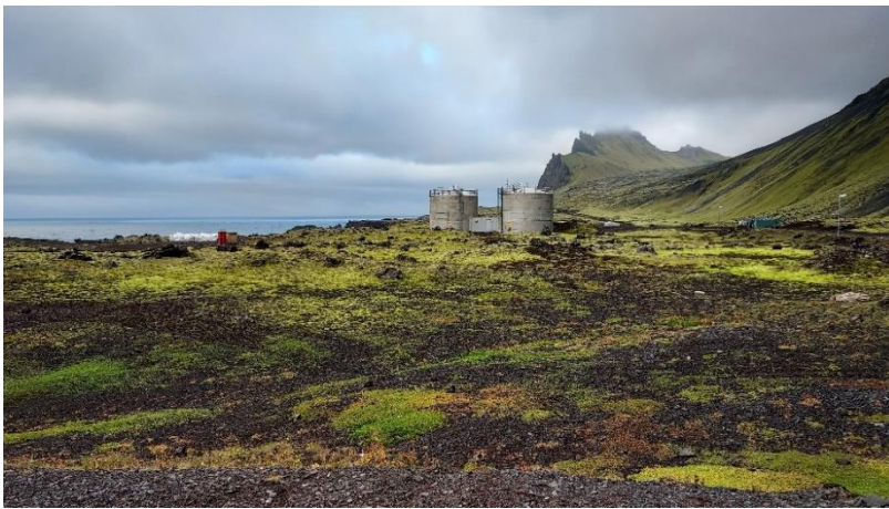
Tankanlegget sett fra stasjonen. Pumpehuset er plassert mellom tank 1 og 2
