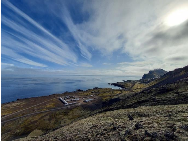
Oversiktsbilde av Olonkinbyen med tankanlegg til høyre i bilde.
