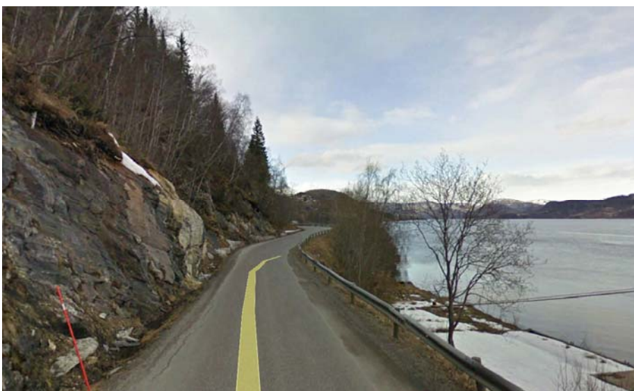
Figur 3: Bilde av bergskjæringen på oversiden av planlagt kaiområde. Bilde er fra 2010. (Kilde:google earth)
