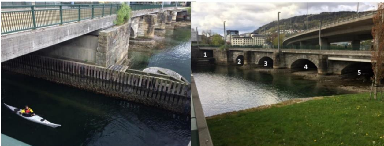
Figur 1. Gamle Nygårdsbro. Løp 2-5 skal mudres for å og gjøre løpene farbare og forhindre rekontaminering av den nye sjøbunnen i prosjektet «Renere Havn Bergen».
