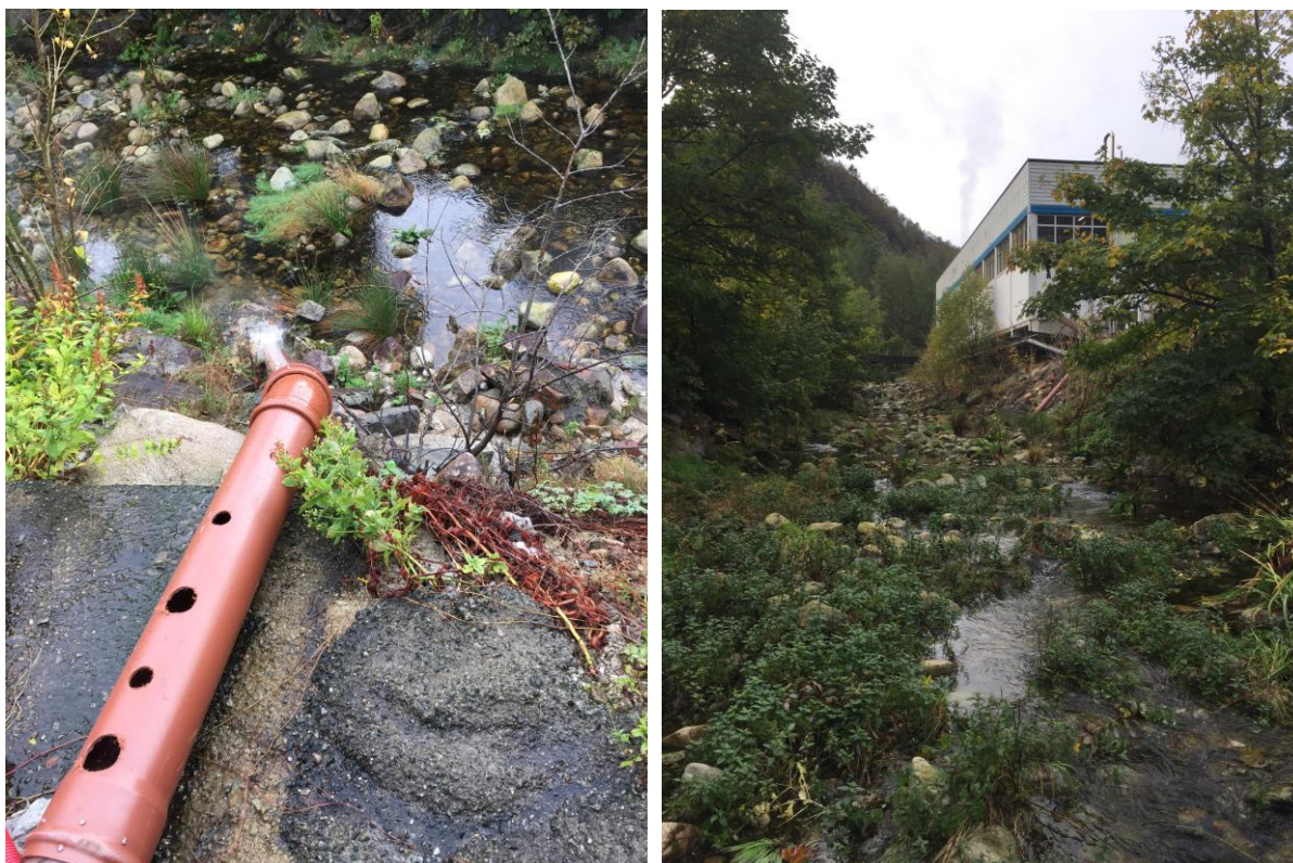
Figur 3.3. Utslipp av kjølevann til Oltedalsåna
