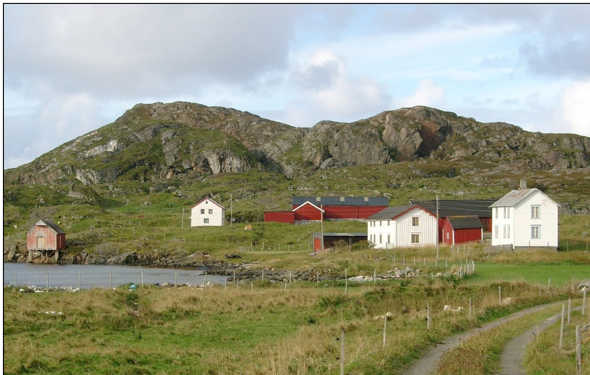
Figur 4. På Allmenningen står det bygninger på seks gårdstun. De fleste er i brukbar stand og det ene fjøset er ennå delvis i bruk.
