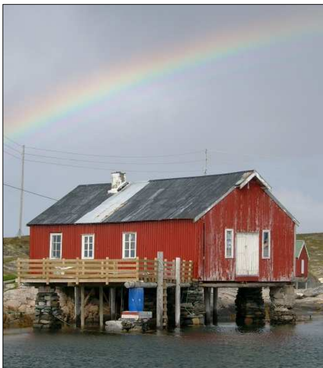
Figur 11. Bygningsmiljøet i Annsteinsundet er av stor bevaringsverdi. Her finnes ennå svært mange rorbuer og brygger som er i god stand.
