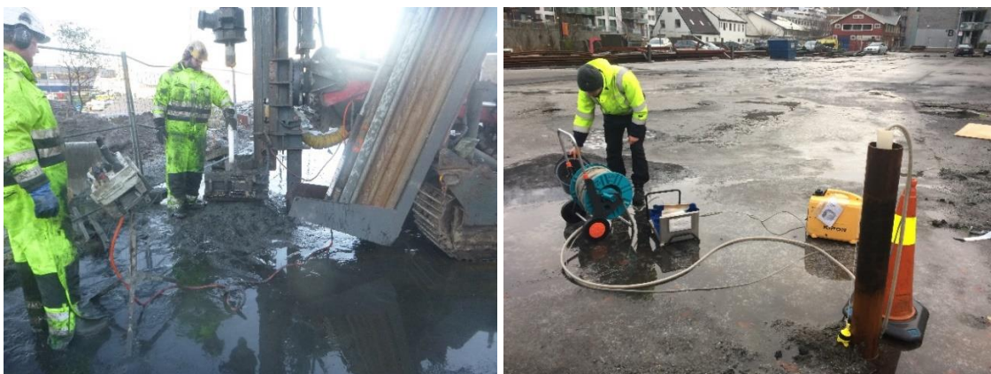
Figur 8 Bilder fra a) innstallering av miljøbrønner og b) pumping/vannprøvetaking i brønner
