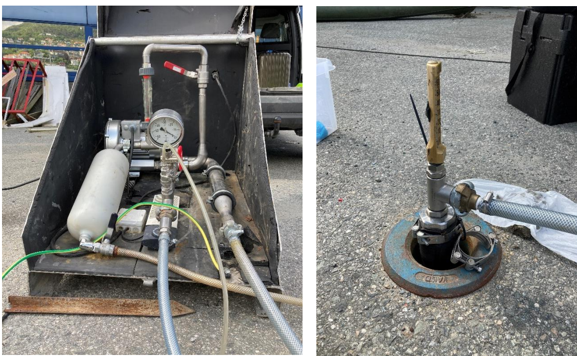
Figur 9 Pumpesystem og tilkobling til brønntopp.
