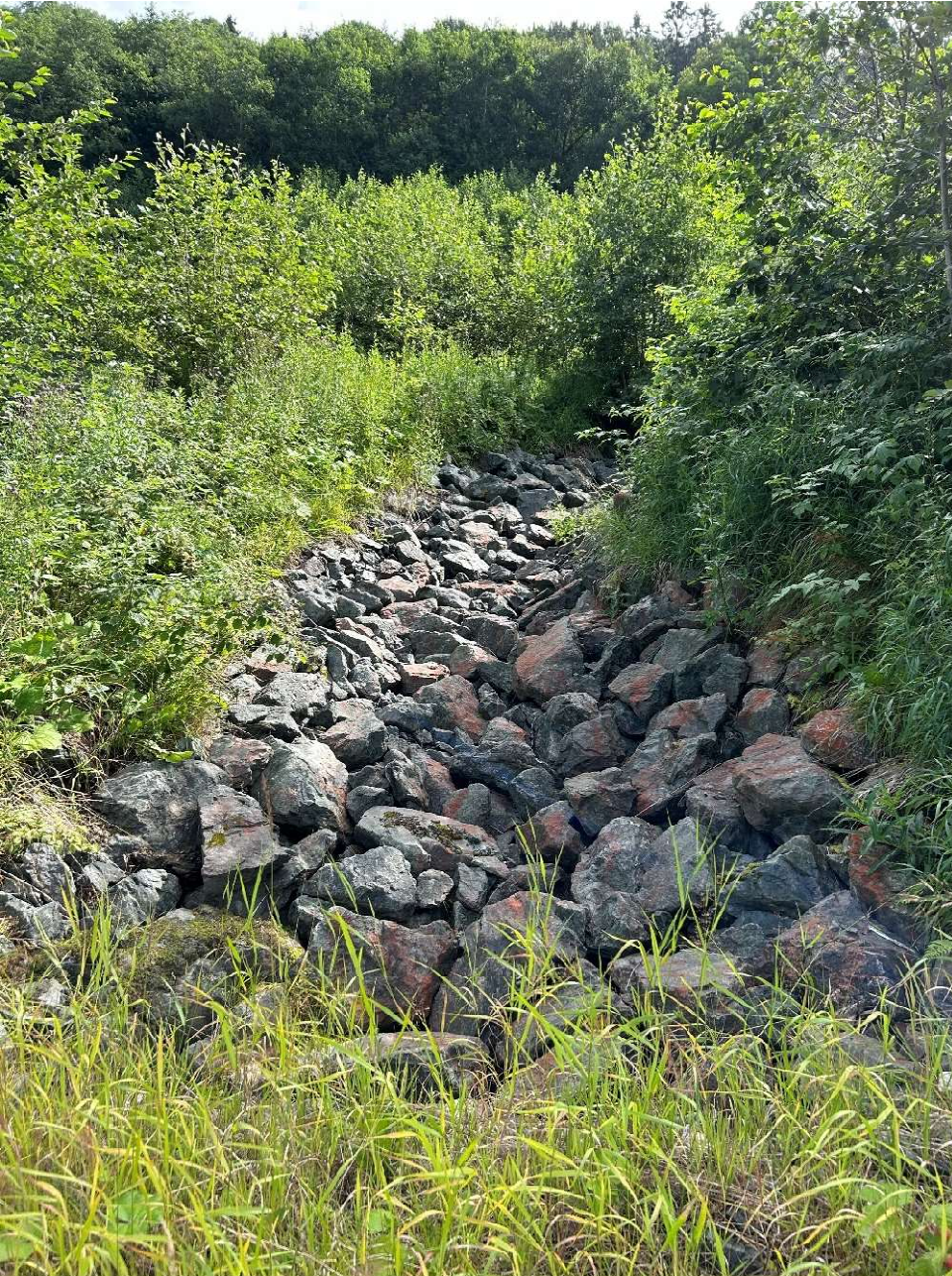
Bilde 1.A: Ingen erosjon, lav vannføring og erosjonssikring i både bunn og sider av bekkeleiet.
