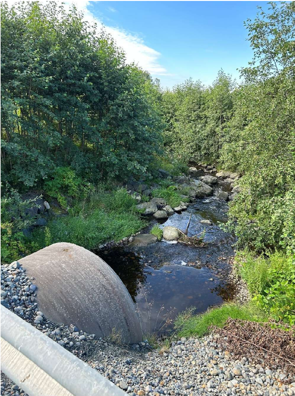
Bilde 2.A: Ingen erosjon. Vegetasjon dekker erosjonssikring i bekkens sider.
