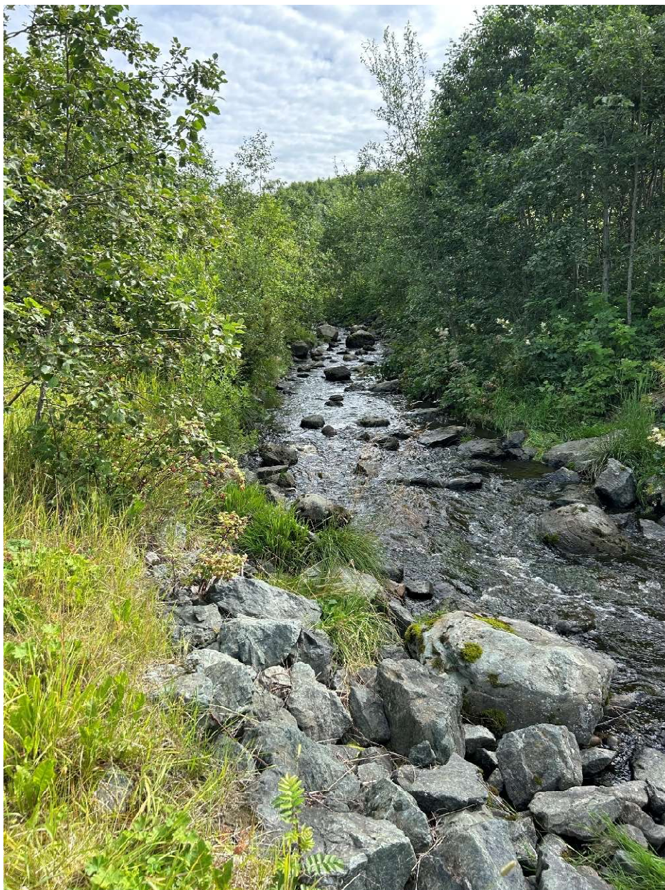
Bilde 2.D: Ingen erosjon. Utpreget erosjonssikring øst for G/S-veg.
