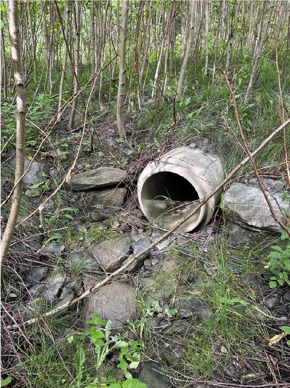
Bilde 1.D: Ingen erosjon. Bekken lagt i rør under skogsveg.
