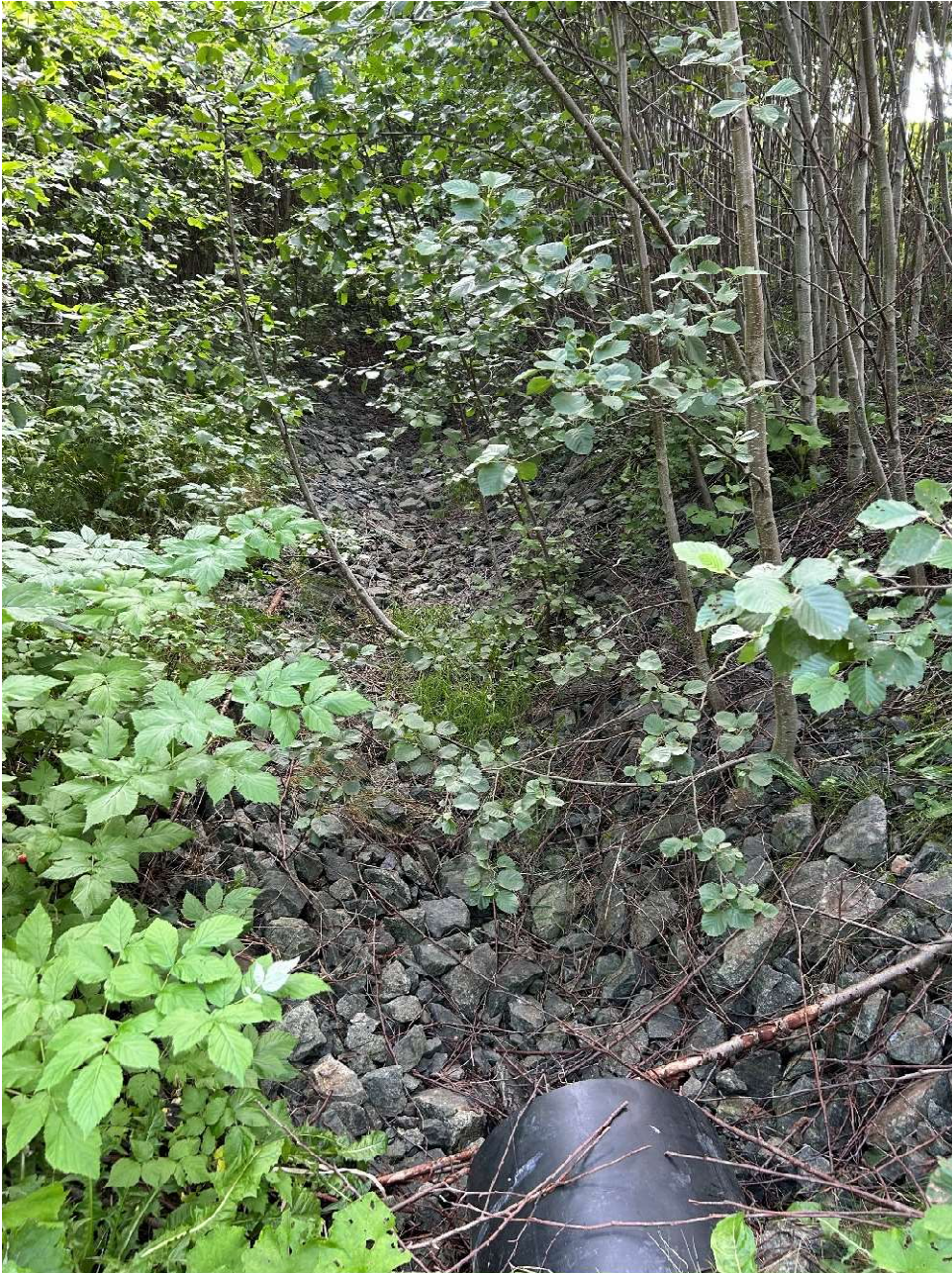
Bilde 3.E: Ingen erosjon. Sidebekk er også erosjonssikret. Ikke synlig vannføring.
