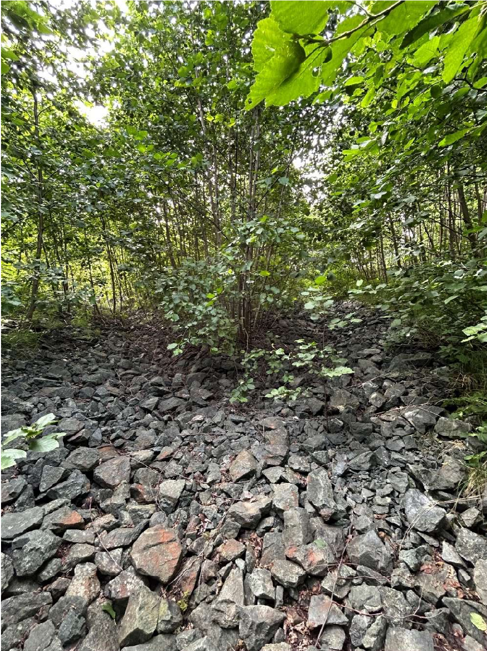
Bilde 1.B: Ingen erosjon. Bildet viser at også mindre sidebekker også er erosjonssikret.
