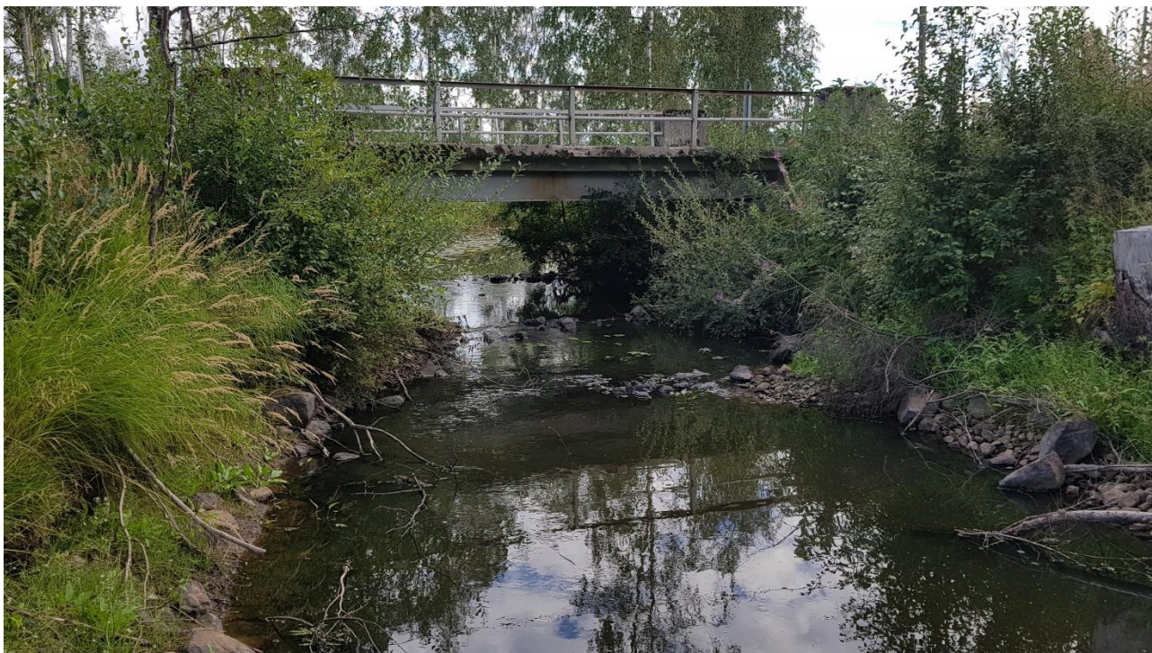
Bilde 1: Bru over Nordre Gjesåsvog sett fra nedstrøms side
