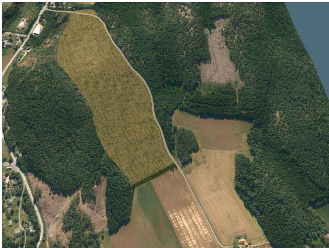
Figur 10. 3D-modell med ortofoto av tiltaket sett ovenfra og fra nordøst
