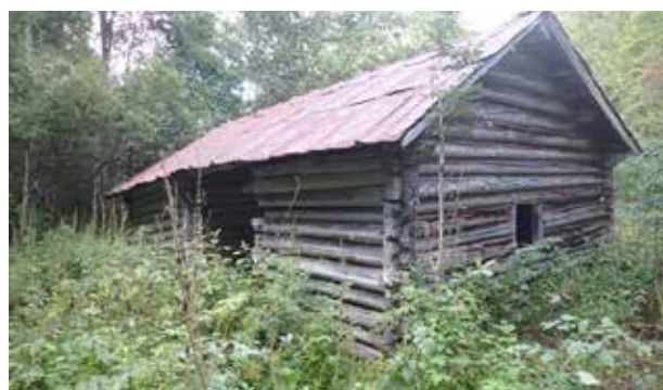
4 Høyløe/sommerfjøs, foto: Jørn Berget
