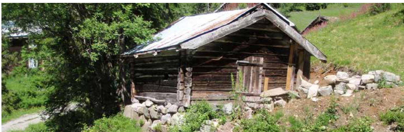
5 Smia er oppført i flat-telgd grantømmer. Den òg ser ut til å vere oppført 1850-1900., foto: Jørn Berget
