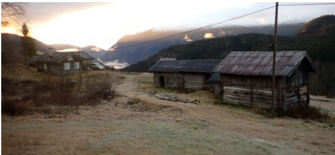
1 Stovebygningen 4 Låve 5 Fjøs, foto: Jørn Berget
