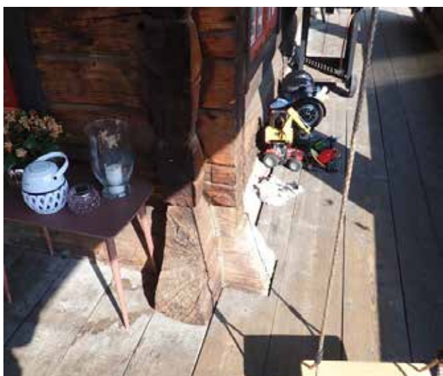
1 Stovebygningen – detalj av hjørnet på lafteverket, foto: Jørn Berget
