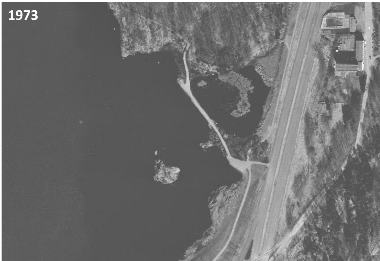
Figur 6. Flyfoto av østsiden av Mosvatnet i 1973. Bukta og østsiden er ferdig utfylt, motorveien er på plass og ny turvei er lagt på fyllmasse over innløpet til bukta slik at Ørnaholmen er så godt som forsvunnet og Andedammen oppstår ved avsnøring fra resten av vatnet. Kilde: www.norgebilder.no
