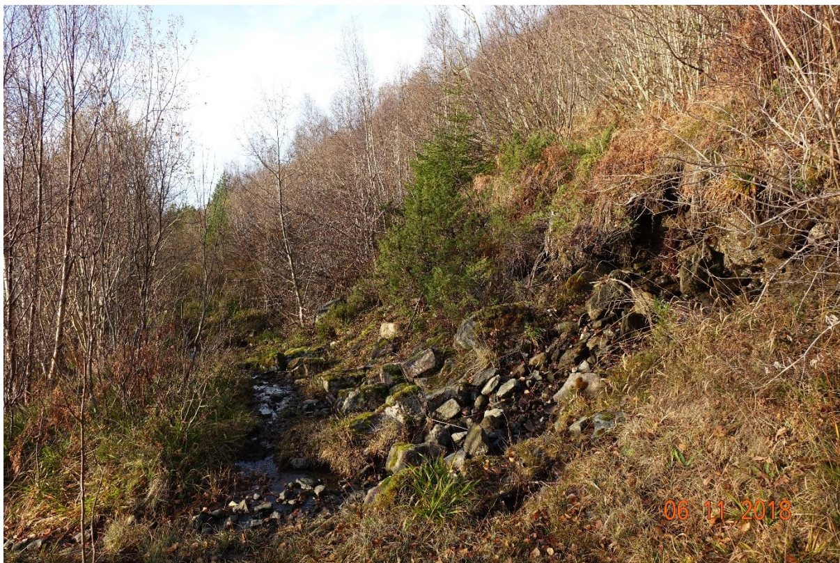
Figur 12: Utgliding på veg observert rett aust for GPS punkt 994.
