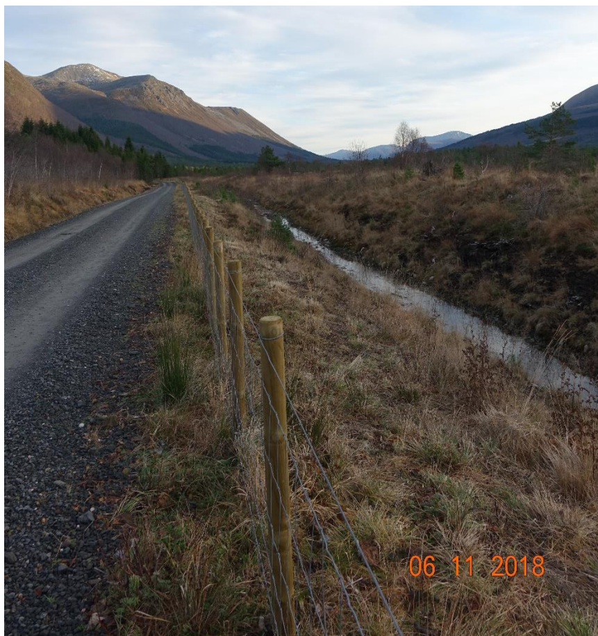
Figur 14: Overvasssgrøft langs med nordvestleg grense av planområdet. Ca. 2 m djup.
