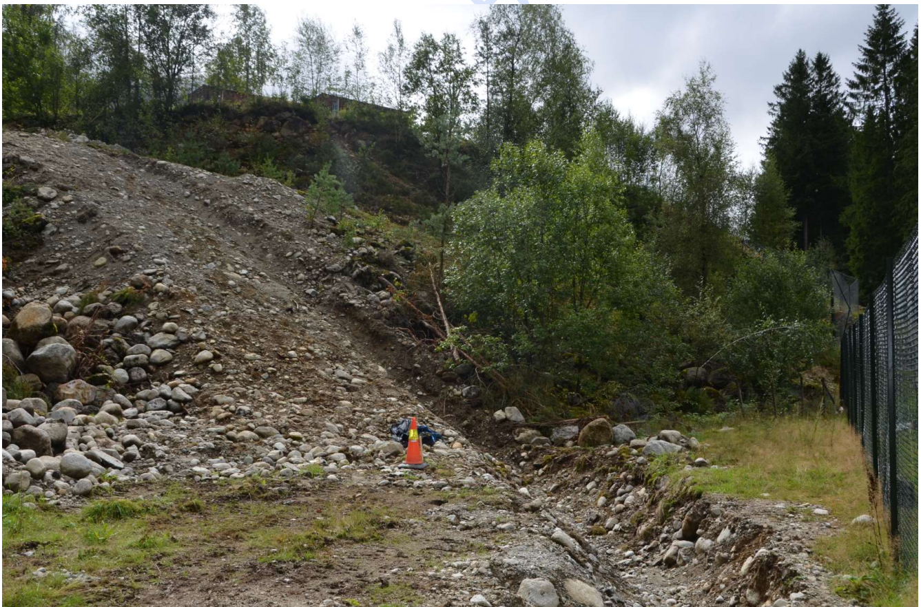
Figur 19 Bildet viser skjæring på deponiets sørvestlige side (område markert med sørligste gul pil i Figur 18). Det ble ikke observert marine avsetninger i skjæringen.
