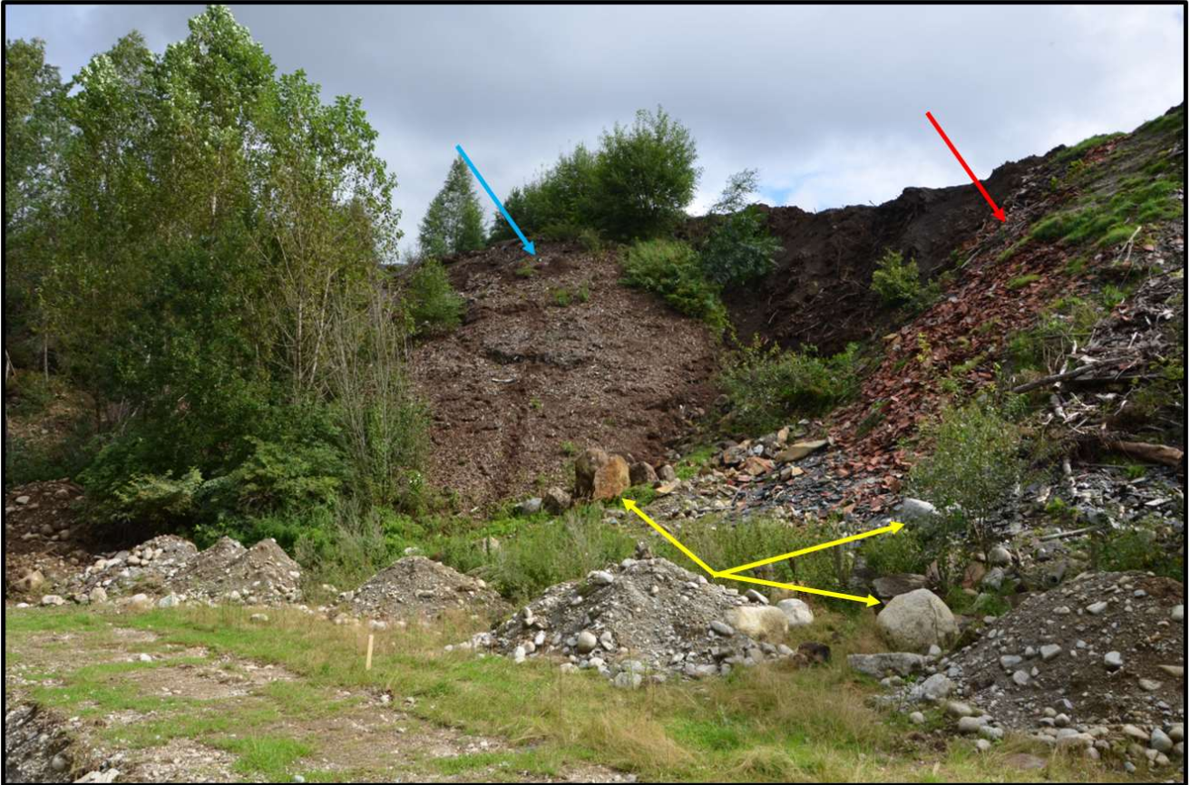
Figur 13 Sentrale deler av deponiet består hovedsakelig av stein, grus og takstein (rød pil), mens det i nedre deler av deponiet observeres større blokker (markert med gule piler). Nordlig del av deponiet fremstår eldre og har toppdekke av bark/kompost (markert med blå pil).
