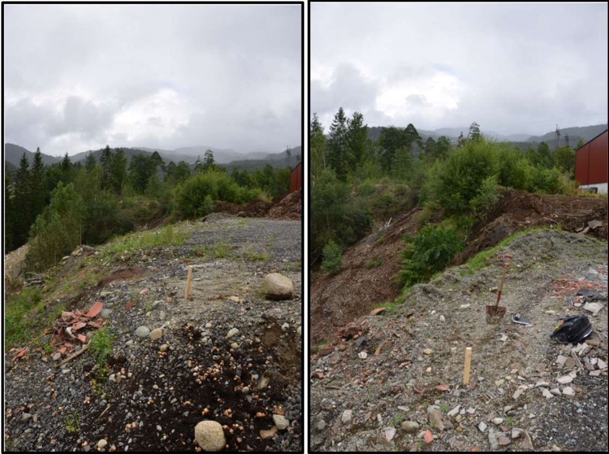
Figur 15 Øvre kant av deponi består hovedsakelig av grus og generelt noe finere masser enn i deponi skråning og nedre del av deponi.
