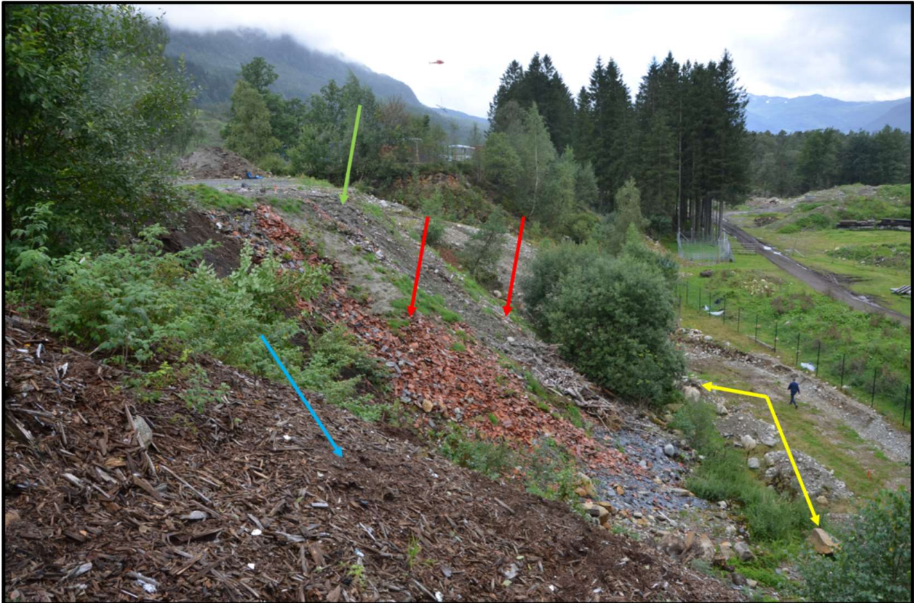
Figur 14 Oversiktsbilde av deponi med større blokker i nedre del (gule piler), takstein og medium størrelse material i midtre del (røde piler) og noe finere masser i øvre del (grønn pil). Bildet er tatt fra lokasjon 7 (Figur 12) hvor deponiet fremstår som eldre og har toppdekke av bark/kompost (blå pil).
