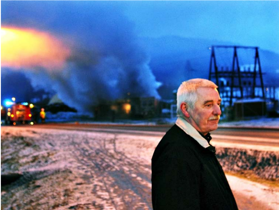
Foto 5 Trafobrann på Orkanger. Foto: Kjell A. Olsen
