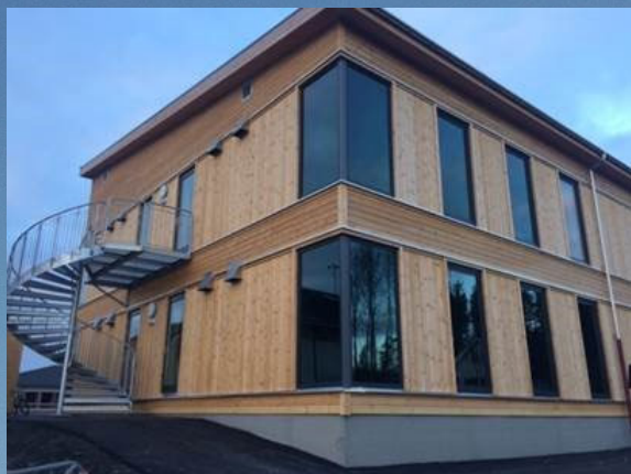
Hanstad skole, Elverum, moduler i massivtre. Ferdig til skolestart høsten 2017. Foto: Hans Erik Skar
