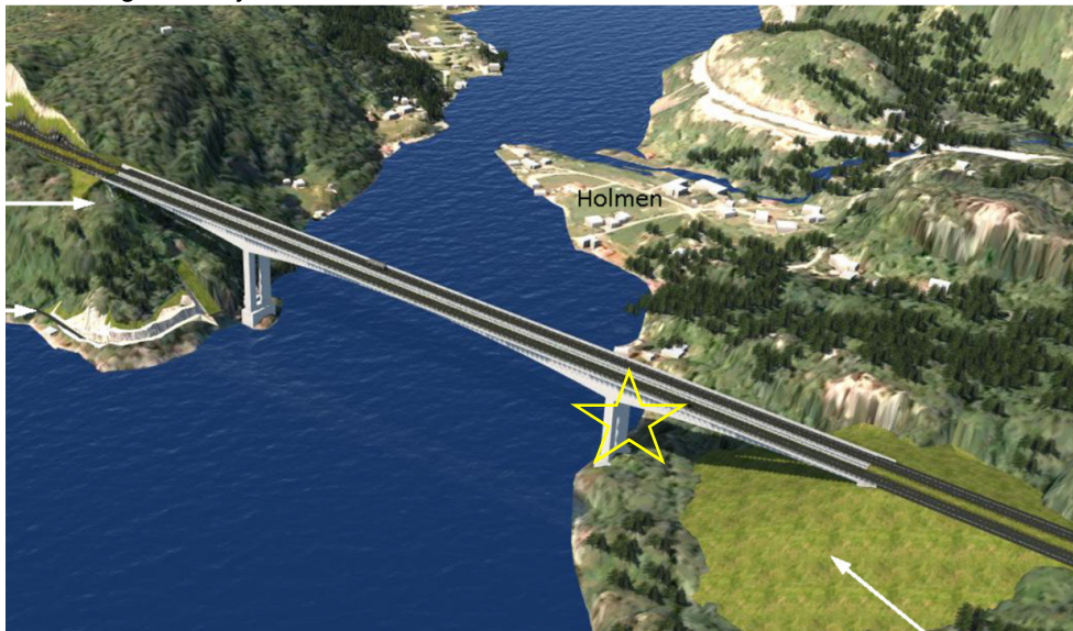
Figur 1: Oversiktsbilde av Trysfjordbru. Veivannet på bruene ledes mot øst. Dryppunktet er markert med en gul stjerne.
