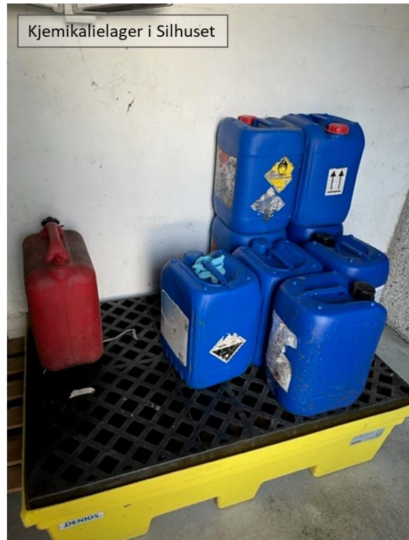
Figur 11: Bildet til venstre: Kjemikalielager på verkstedet/hovedbygningen. Skapet er sikret med hengellås. Bildet til høyre: kjemikalielager i Silhuset. Dunkene er i bruk, og lagres over rist som samler opp eventuelle utslipp.
