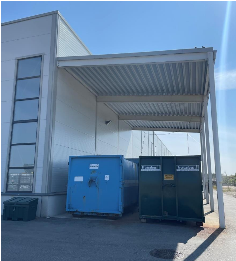
Figur 23. Komprimator og lukkede containere til oppbevaring av restavfall. Separat container for papp, farget plast og blank plast.
