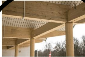
Bygg med tre
