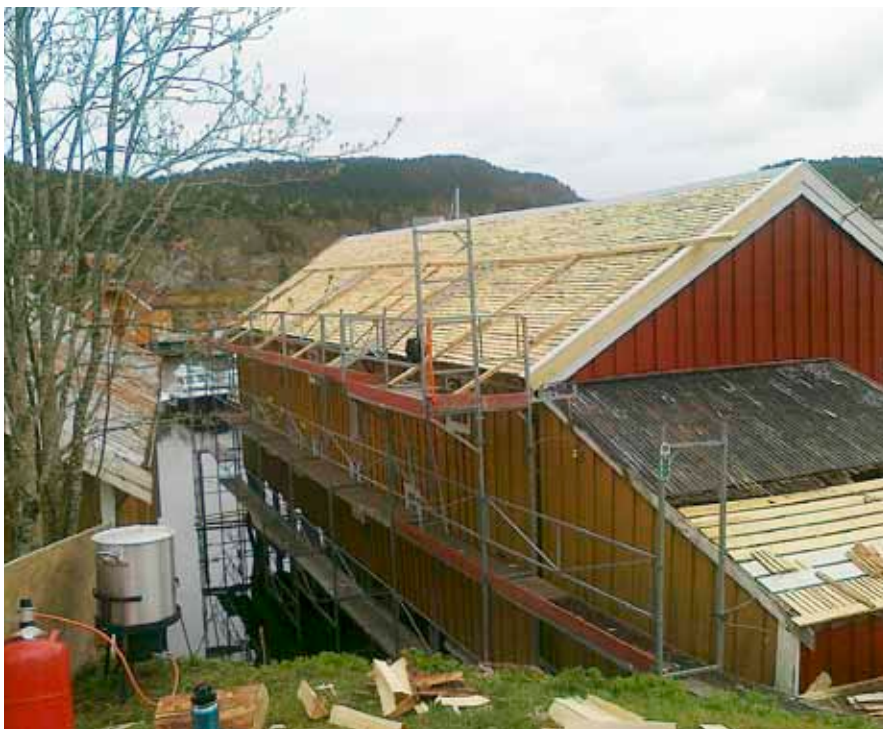
Tak som settes i stand ved bruk av samme type materialer og samme teknikk som den gang det var nytt.
