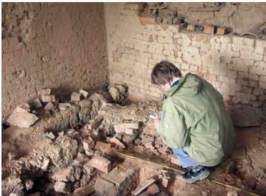
Reparasjon av mur framfor utskifting er i tråd med retningslinjene SMIL følger.
