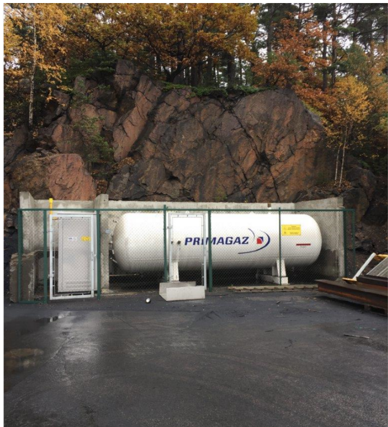
Figur 10: Viser anlegg for gasstank ved industrianlegget.
