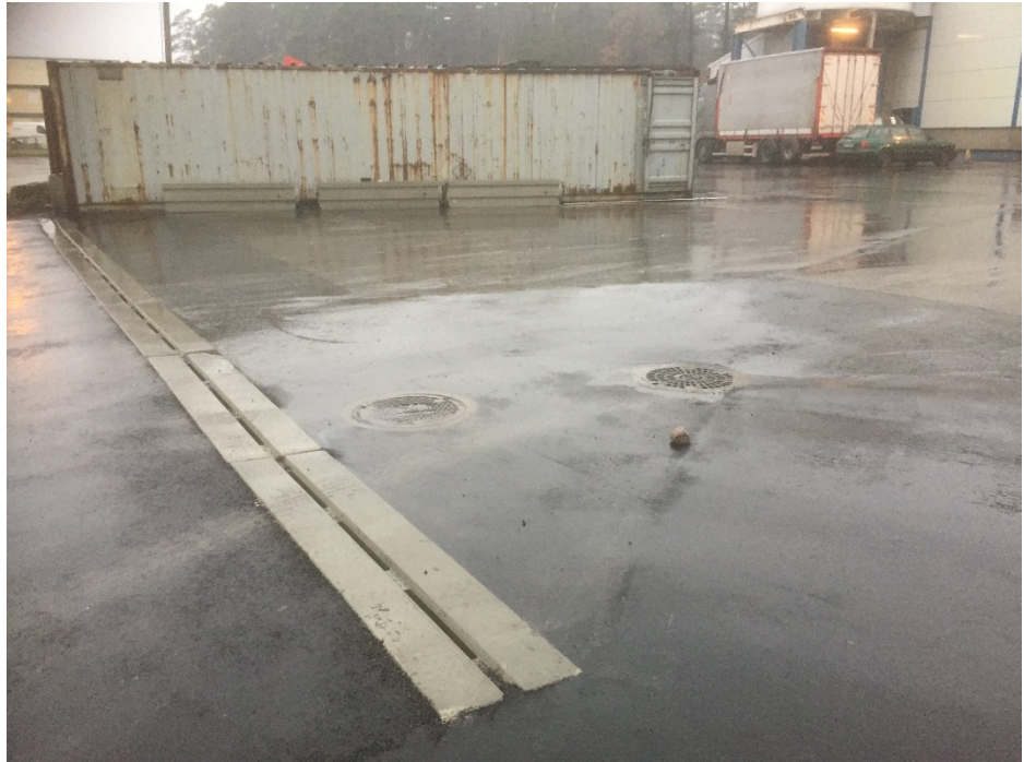
Figur 9: Viser dagens innkjørsel etter installasjon av sandfilter og oljeutskiller,
