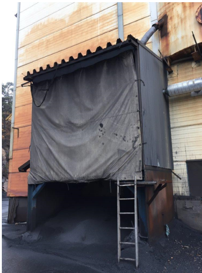
Figur 5: Viser oppsamlingssted for spilt råstoff. Mestdelen (under tilbygg) tas ut og kjøres tilbake i prosessen mens store- og harde klumper tas ut til høyre for stigen og leveres til mottak. Støvet ifra sikteprosessen samles opp i et nytt filter. Ref. figur 6.
