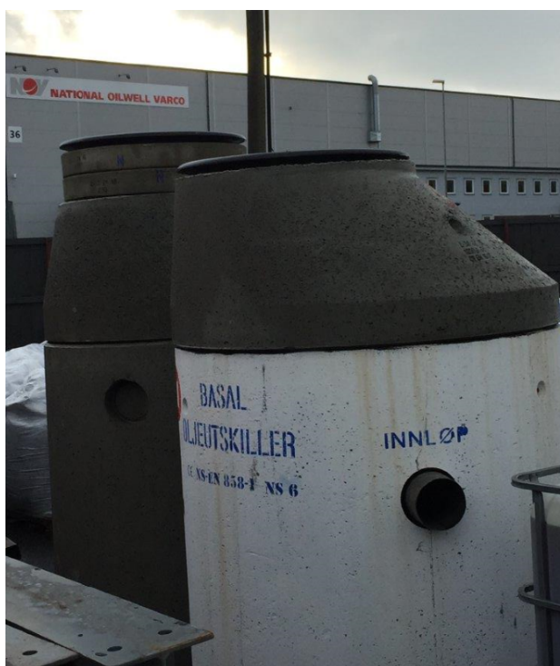
Figur 8: Viser bilde av kum med sandfang og oljeutskiller før installasjon.
