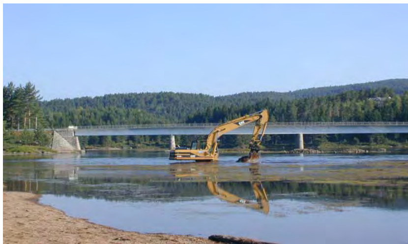
Gravemaskin i arbeid på Sveindal i Mandalselva. Foto: Edgar Vegge.
