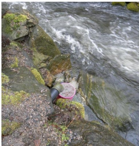
Figur 2-2: Utslippspunkt fra renseanlegg til Sjølingstadbekken. Foto: Multiconsult v/Askland 28.02.2017.
