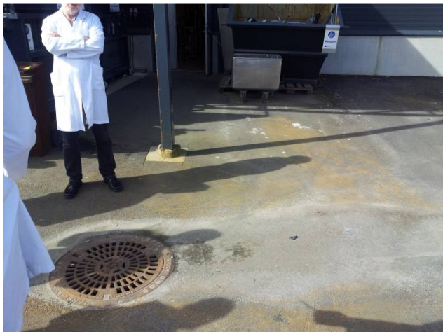
Fig. 1: Kum ved lager for farlig avfall
